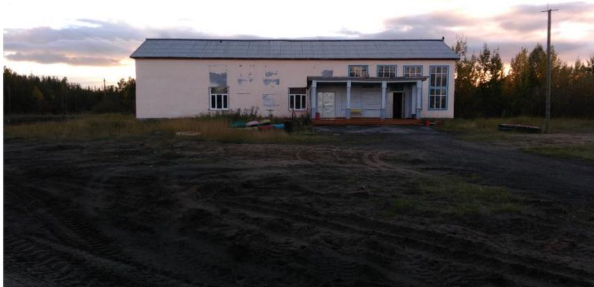
**СТАЛО.** Теплоизоляция стен здания (утепление снаружи), замена окон.
